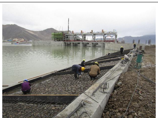
两岸防护堤施工
