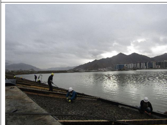
两岸防护堤施工
