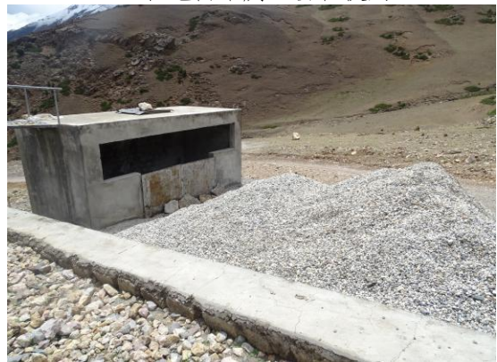
营地外的生活垃圾收集池
