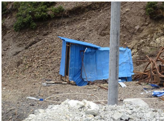
4700m 的 PD9 坑道西侧旱厕( 修缮后可使用 )
