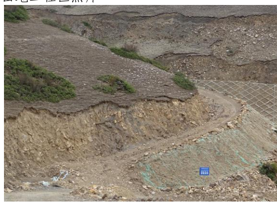
勘查区既有道路
