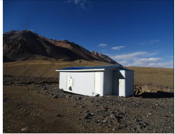
矿区现有旱厕现状
