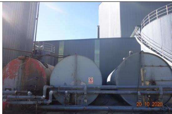
导热油储罐 (3个 20m<sup>3</sup>)
