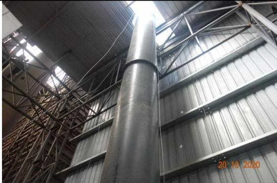
骨料预处理系统排气筒（1#排气筒，32m）
