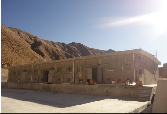
硝酸铵储存库
