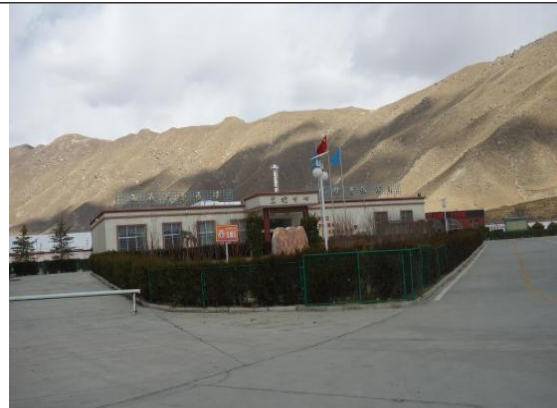
库区东南面的乳化炸药生产线
